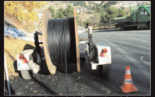
Installation de la fibre optique à Aussois.
