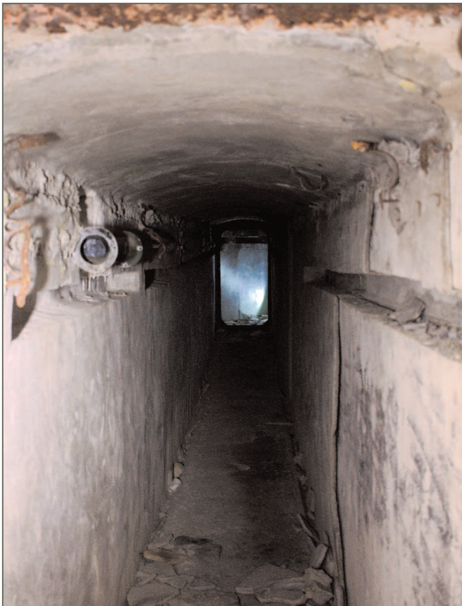
Les renforcements à gauche et droite dans les murs ne servaient pas à faire passer des câbles ou des réseaux mais à guider les hommes. En cas de coupure d'électricité, les soldats se retrouvaient plongés dans le noir le plus complet. Pour retrouver la sortie, il "suffisait" de tendre la main et de suivre les renforcements.
