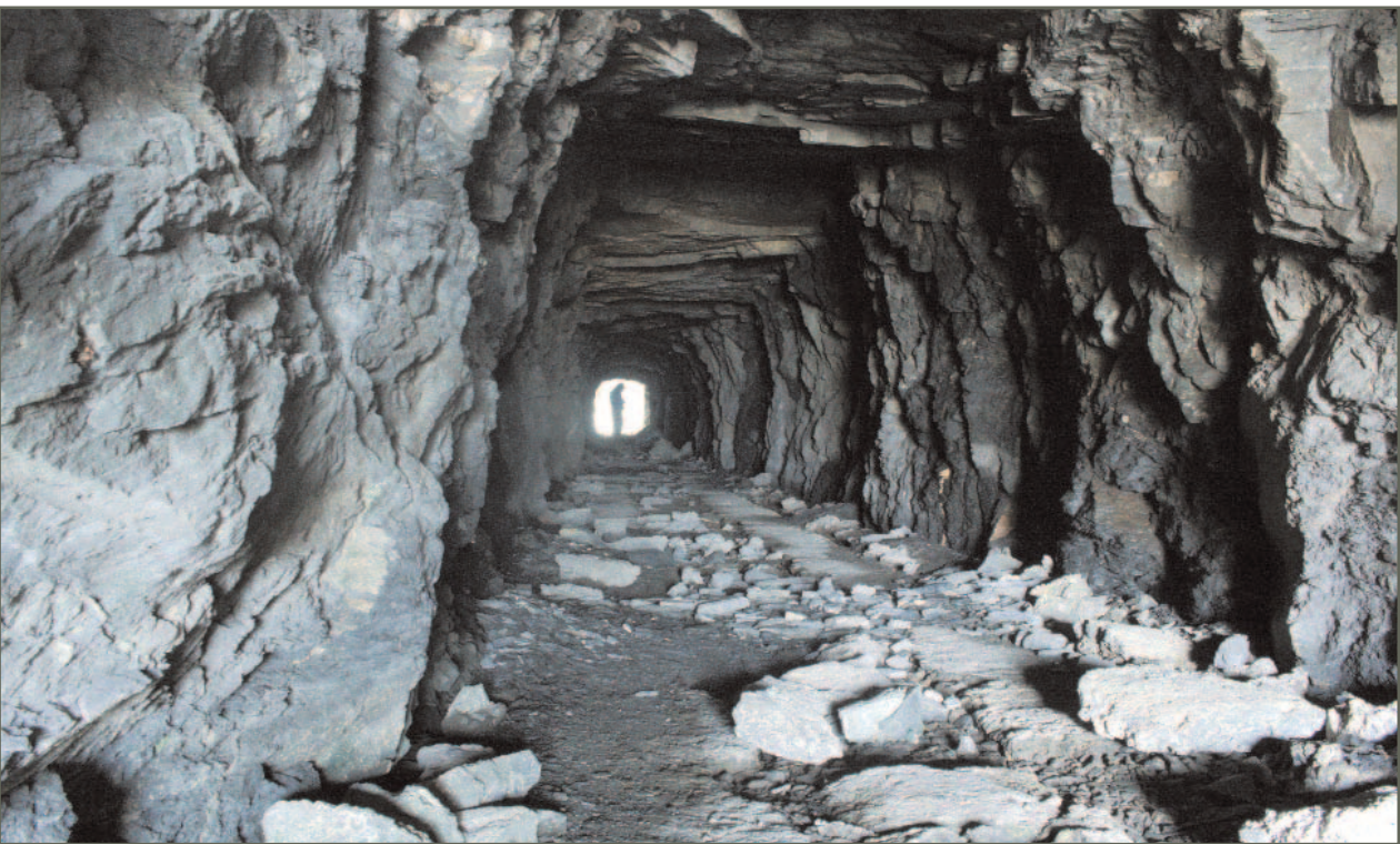
Galerie d'accès à la gare d'arrivée du téléphérique du Pas des fenêtres : une immense grotte qui donne sur le vide.
