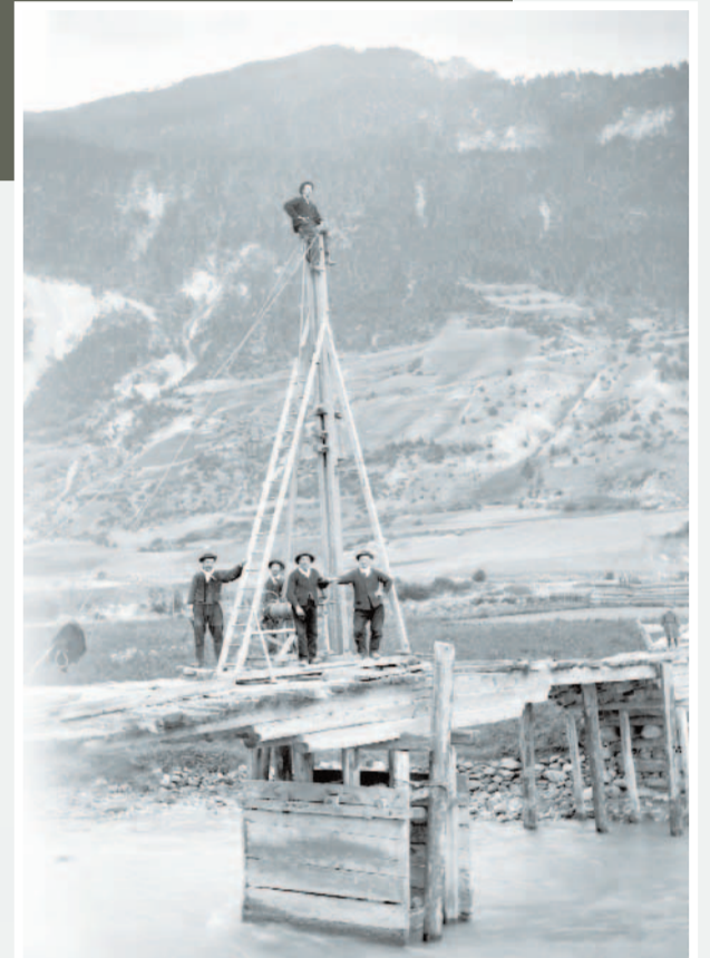
Une sonnette servant à enfoncer des pieux lors de la construction d'un pont à Bramans.
