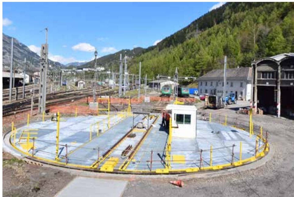
13 mai, le nouveau pont tournant est presque terminé !
