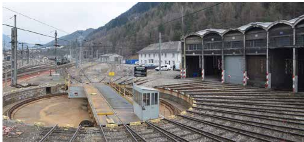
2 avril, avant les travaux...
