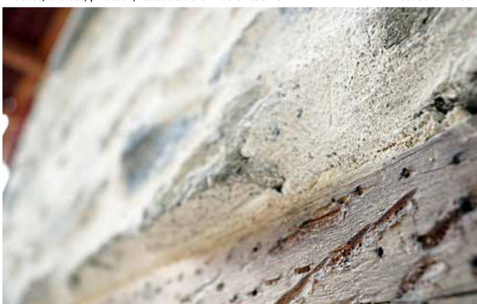
Détails de l'enduit sur un support bois.
