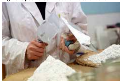
Truelles, brosses, pinceaux, les outils de la mise en œuvre
