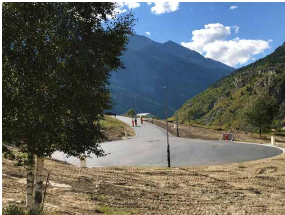
L'extension de la ZAE des Terres Blanches prend forme. Vue de l'aire de demi-tour pour les poids-lourds.
