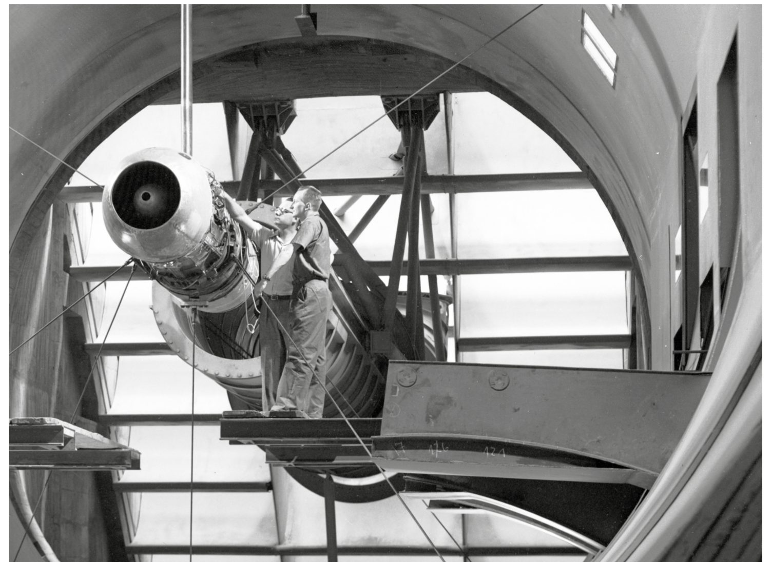
1948, on remonte une prise de guerre alliée démontée dans une vallée autrichienne. La plus grande soufflerie du monde s'installe à Avrieux. Quelques années à peine plus tard, débutent les premiers essais aérodynamiques sur des structures et pièce d'aéronefs, et autres engins volants... Photo archives ONERA
