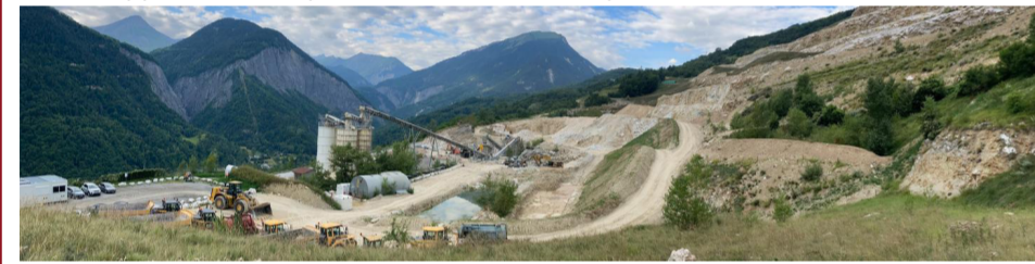
La carrière de gypse de Saint-Jean-de-Maurienne
