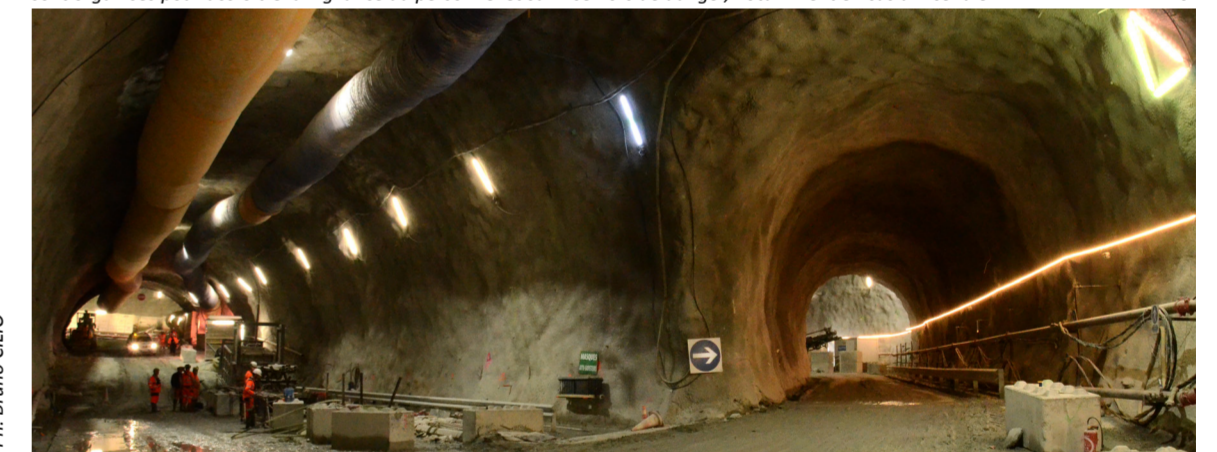
Confluence de galeries à 500 m de la surface
