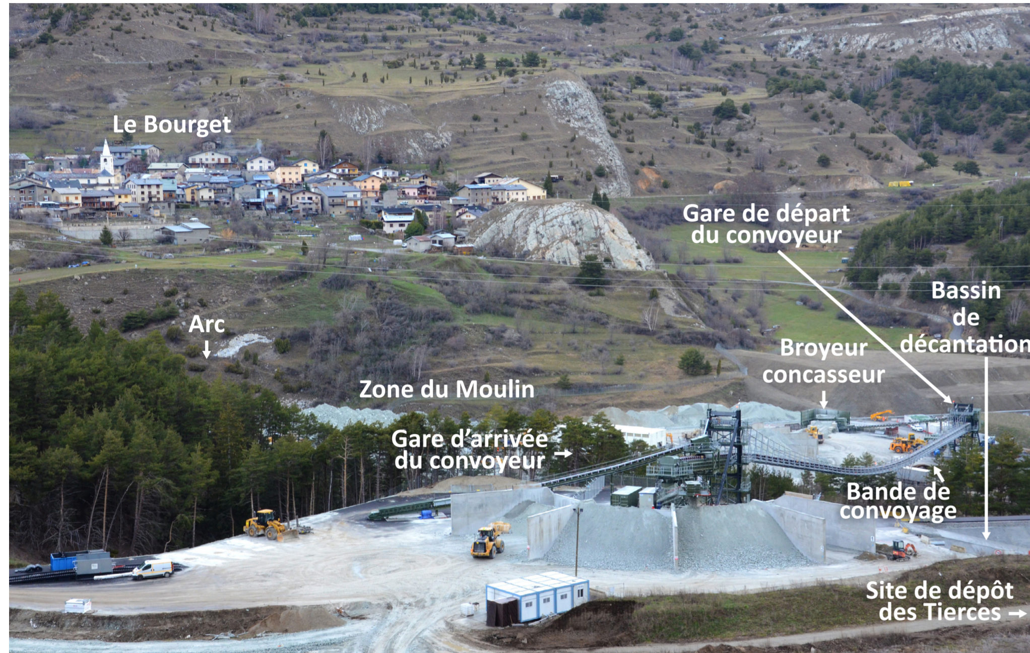
Une photo inédite des installations TELT de surface et leur forte emprise sur le paysage. Les matériaux d'excavation des chantiers des puits d'Avrieux et de creusement de galeries et de cavernes pour le montage des tunneliers, à - 500 m, sont remontés en surface par dumpers, via la descenderie, sur le site du Moulin, rive droite de l'Arc. Ils y sont concassés puis calibrés et transportés jusqu'à la gare d'arrivée, rive gauche de l'Arc, par la bande de convoyage, longue de 285 m, puis stockés aux Tierces ou valorisés. Ph. Bruno CILIO
