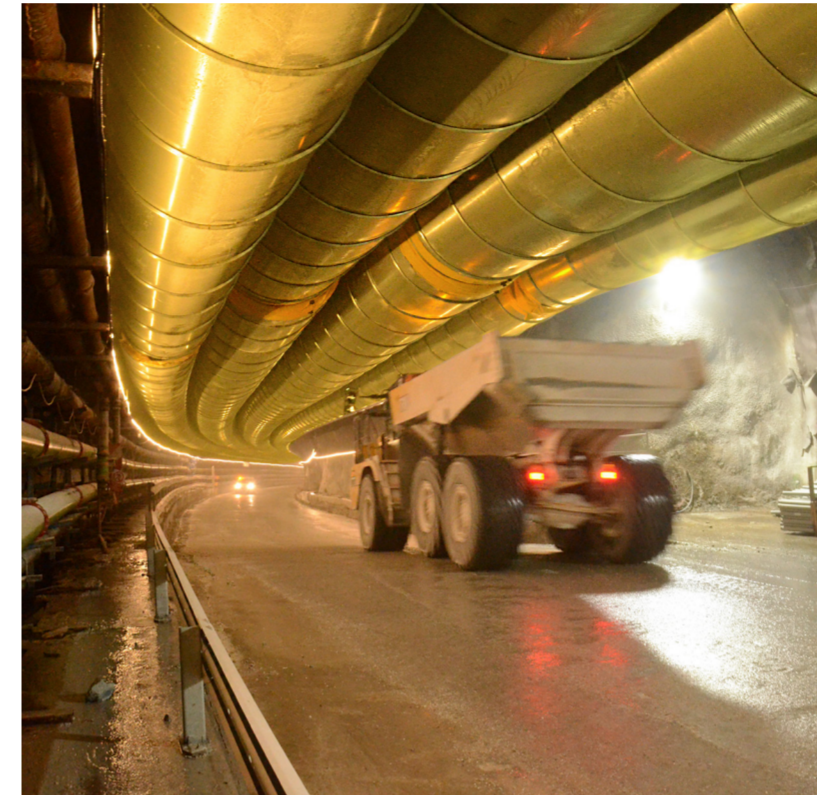
Longue de 4 036 m, la descenderie de Villarodin-Bourget donne accès aux multiples chantiers à la cote - 500, dont celui du percement des puits d'aération et des cavernes techniques où seront montés les tunneliers qui entameront le creusement des tubes du tunnel de base, vers l'Italie. C'est par cette galerie que les matériaux d'excavation sont remontés, sur dumpers.
