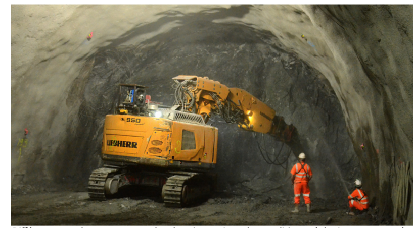
Différents types de percement sur les chantiers, suivant les conditions géologiques rencontrées et l'objectif poursuivi : engins équipés de marteaux hydrauliques, abattage à l'explosif, tunneliers pour réaliser les tubes du tunnel de base.
