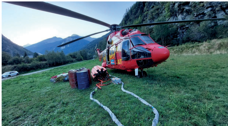
Dimanche 24 septembre, un hélicoptère Super Puma a été utilisé dans le cadre des premières purges dans la paroi de la falaise, il a largué près de 68.000 litres d'eau. On emploie ici les grands moyens et c'est même une première en France, la purge hydraulique a consisté en plusieurs largages consécutifs d'eau sur des zones instables. Au total l'hélicoptère a effectué 17 largages d'eau. Opération qualifiée de succès, avec le décrochage de beaucoup de matériaux meubles instables, indique SNCF Réseau. Il y aura d'autres purges dans les semaines suivantes. Photo SNCF RESEAUX.
