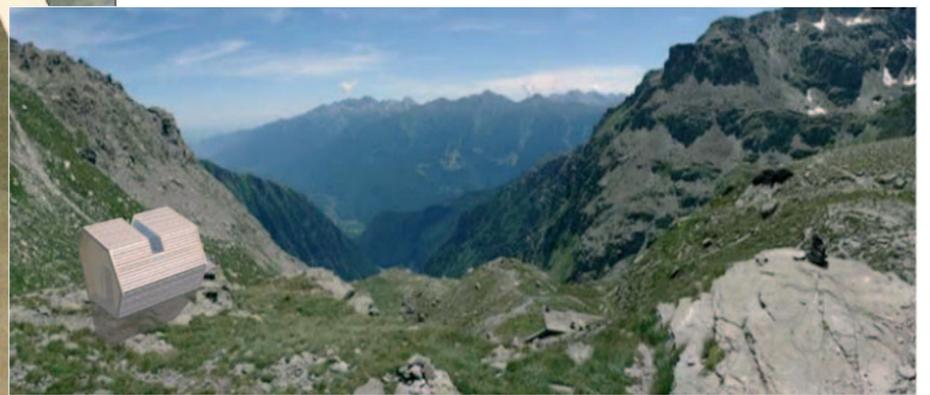
Hexagone en structure bois, ce bivouac au design moderne offre 8 couchages. Matelas, vue imprenable sur l'Italie et verrière permettant de profiter du ciel étoilé attendent les randonneurs dès la mi-septembre. Monté une première fois à Giaglione, le bivouac a ensuite été démonté, hélicoptéré en kit puis installé sur des pylônes de béton au col Clapier. L'inauguration officielle est prévue le 4 octobre.
