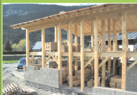
Isolation en chanvre en Haute Maurienne. Un isolant qui se présente sous la forme de blocs faciles à poser.
