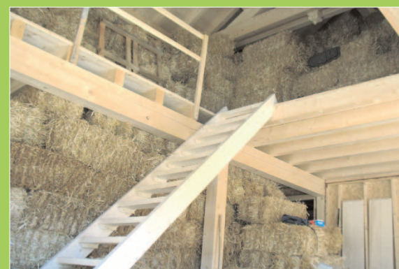
Une grange ? Non, l'isolant prêt à être installé.
