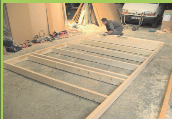
Assemblage d'une paroi pour une maison en bois en Haute Maurienne.
