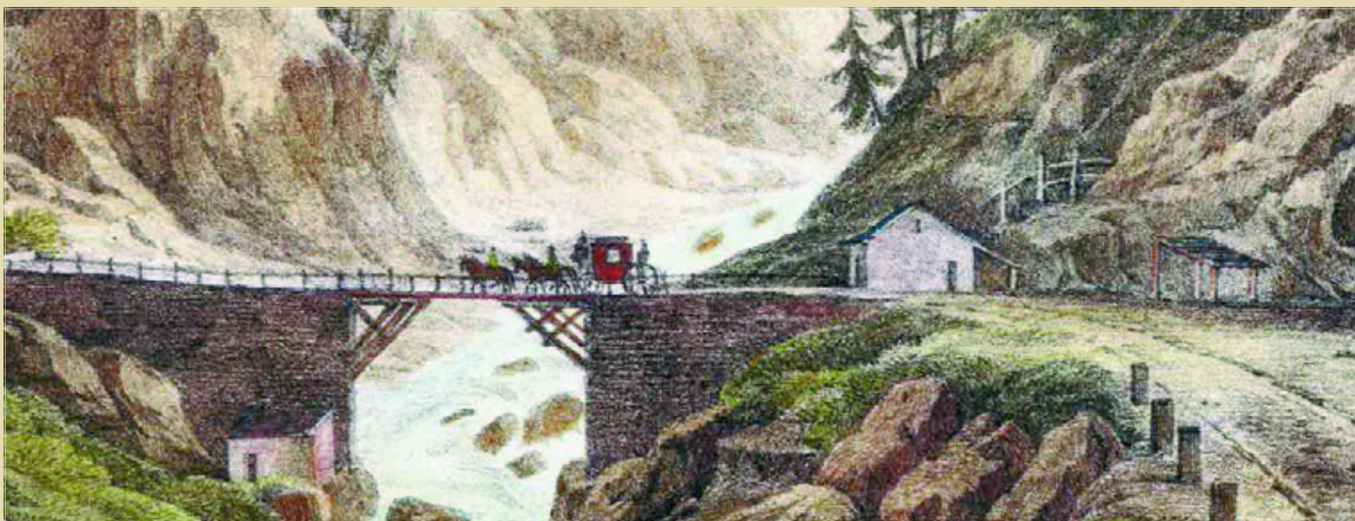
Le pont du Nant, gravure du major James Pattison Cockburn (1821). On voit bien ici la technique du pont "fusible". En cas de crue, le tablier en bois saute rapidement, mais les culées maçonnées restent en place. Le pont peut ensuite être facilement reconstruit. A noter que la gravure mentionne le pont du "Nor" près de "Fort Roussillon", des approximations qui ne font cependant pas douter de la fidélité de la vue : le major Cockburn était en effet considéré comme un remarquable aquarelliste et topographe. Il a dessiné de nombreuses vues de la vallée lors de son passage en Maurienne et a publié plusieurs ouvrages, dont l'un sur la route du Mont Cenis.
